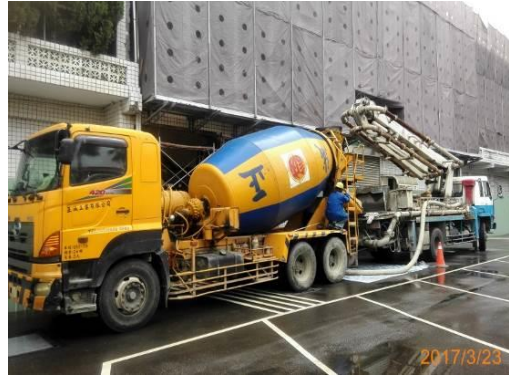
106.03.23 F2 基礎處坡道進出
