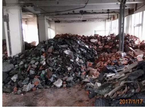
106.01.17 拆除數量龐大
