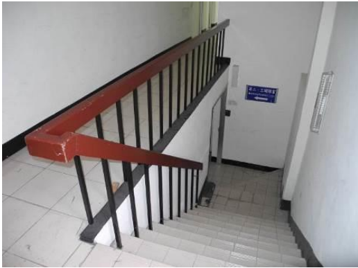
104.11.20 1F 往地下室樓梯
