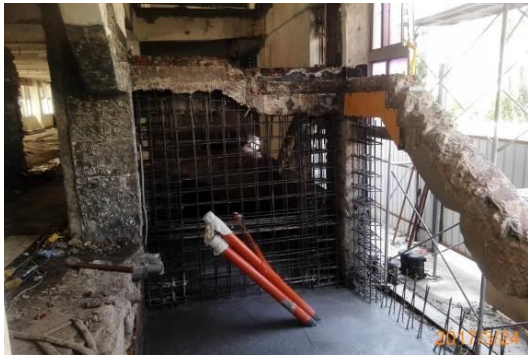
106.03.24 舊有樓梯拆除復原
