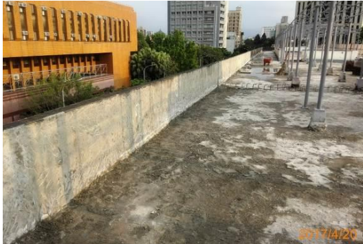
106.04.20 防水坡度施作
