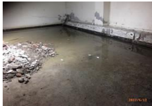
106.06.12 地下室漏水處理
