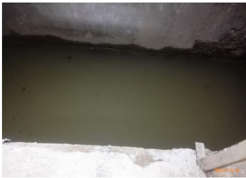
106.05.08 貨梯機坑漏水處理
