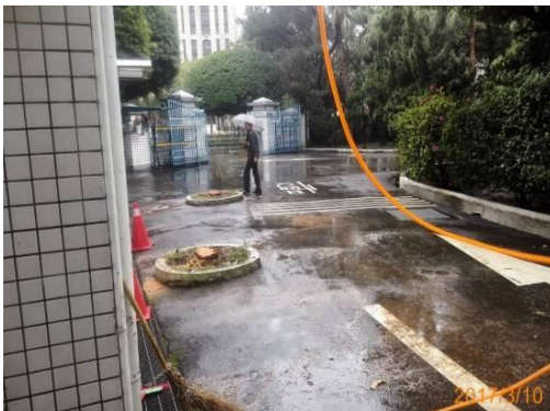
106.03.10 F3 基礎外側椰子樹移除
