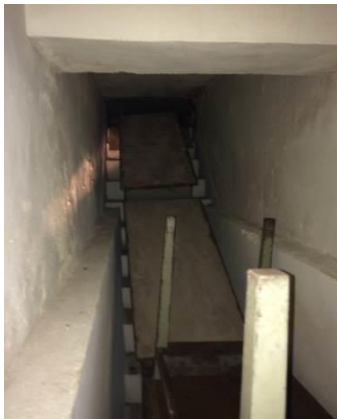
104.11.20 B1F B 棟樓梯
