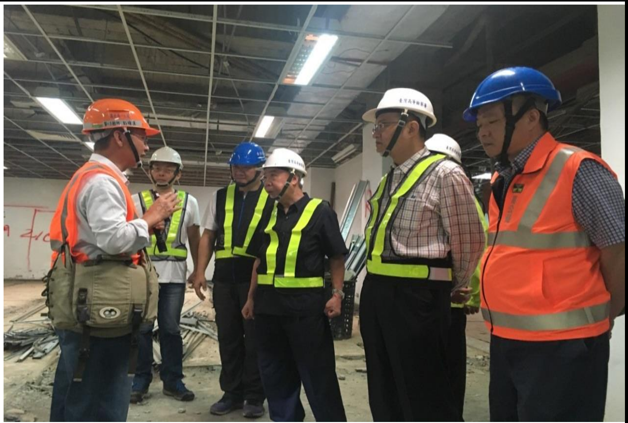
本署王添盛檢察長（前排右起第 3 人）巡視博一大樓施工情形《攝於民國 107 年》
