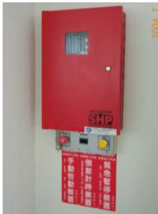
氣體式自動滅火設備(左上：控制盤、右上：氣體鋼瓶)、
