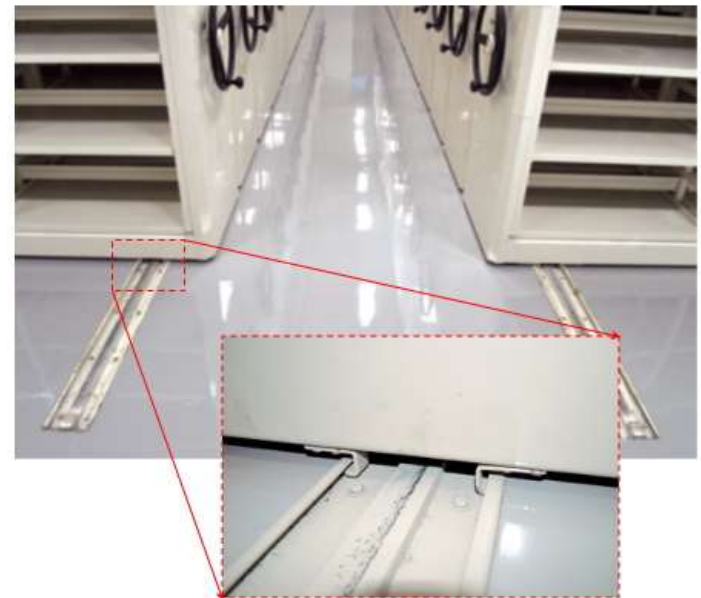
密集式檔案架防傾倒卡桿
