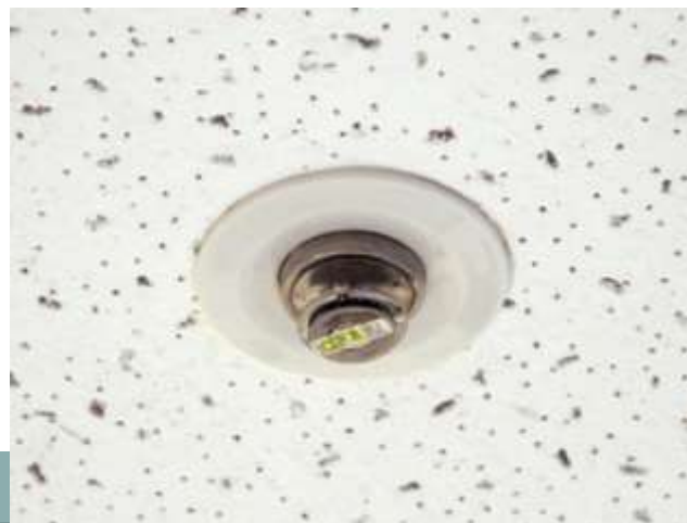
自動撒水滅火設備撒水頭
