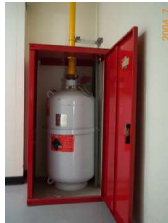
氣體式自動滅火設備(左上：控制盤、右上：氣體鋼瓶)、
