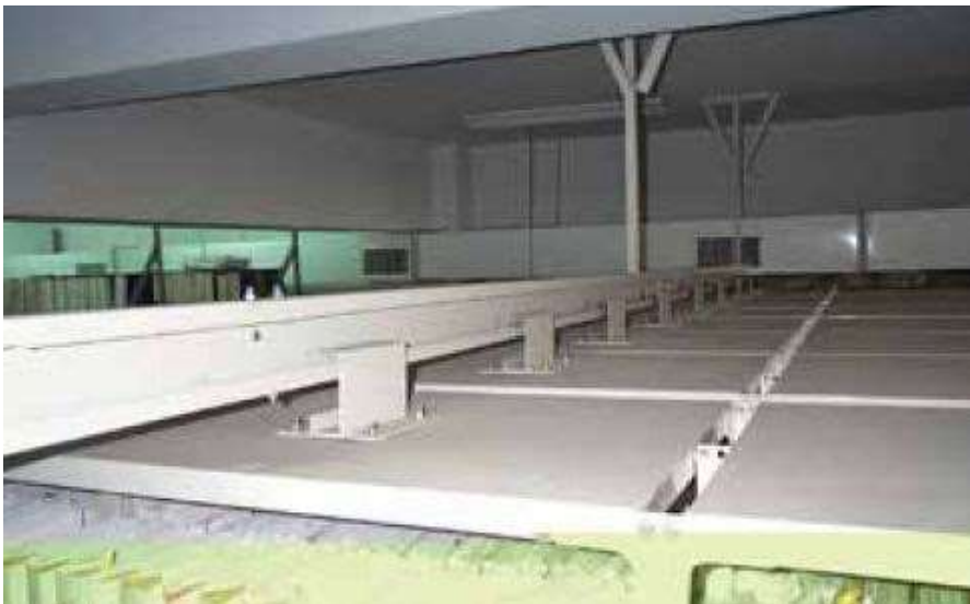
密集式檔案架防傾倒連桿
