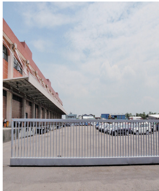
南區大型贓證物庫（攝於 106 年）。（本署資料照片）
