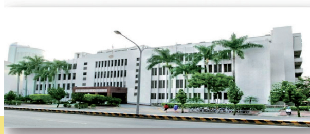
院檢辦公大樓現況 / 臺南高分檢署
