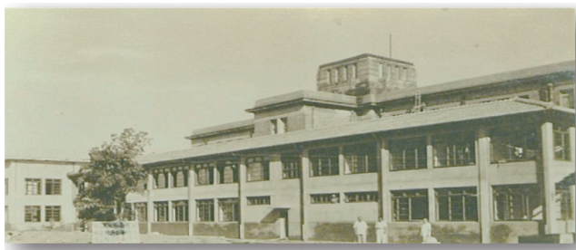
42 年增建辦公大樓施工狀況 / 臺南高分檢署
