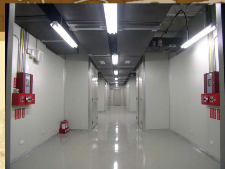
採用金屬庫板方式處理 之分間牆案例
