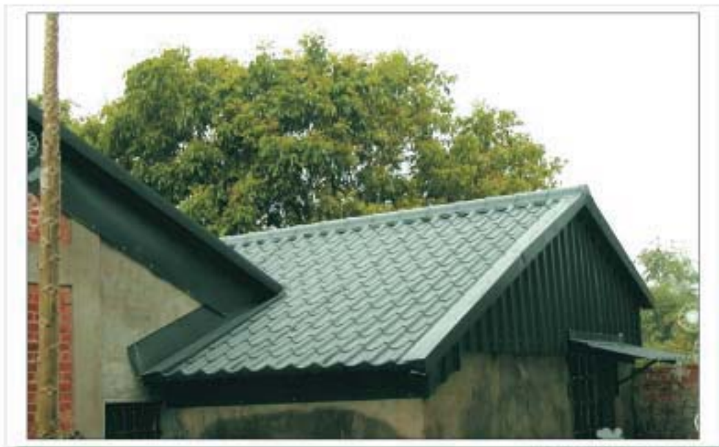
單身宿舍屋頂整修完成
