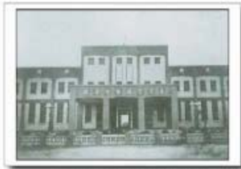
建築完成之雲林地院大廈正面
