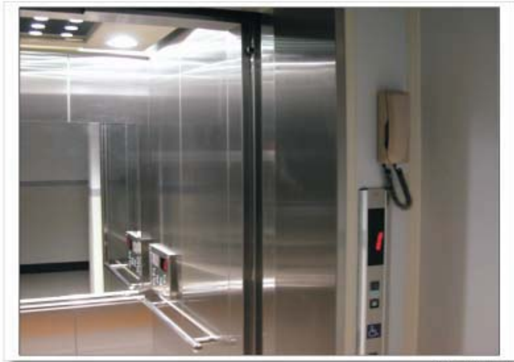
貨梯興建完成
