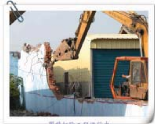
圍牆拆除工程進行中
