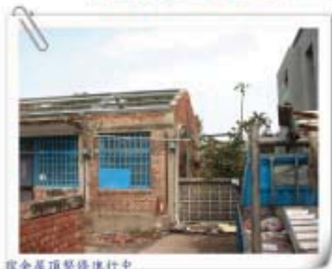
宿舍屋頂整修進行中
