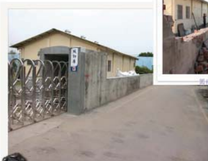
圍牆拆除工程完工
