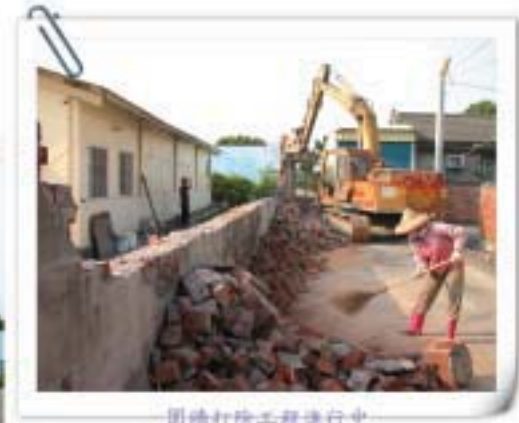
圍牆拆除工程進行中
