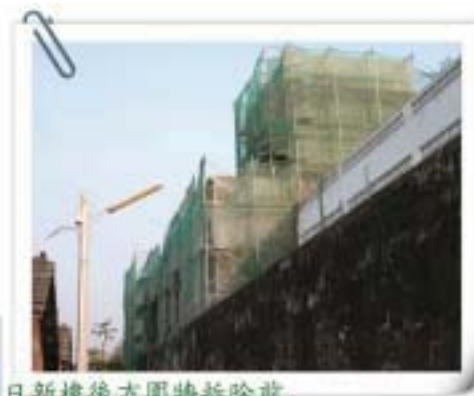
日新樓後方圍牆拆除前
